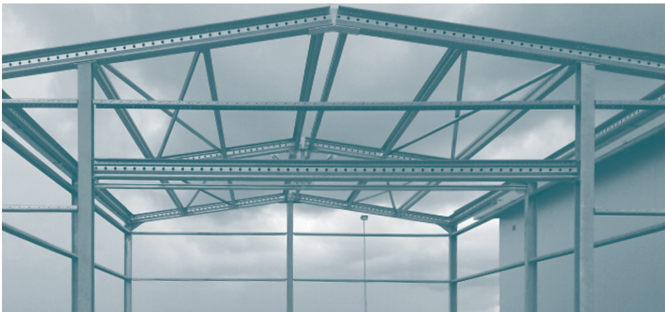
Realizzazione di una copertura a doppia falda per un capannone di piccole dimensioni
