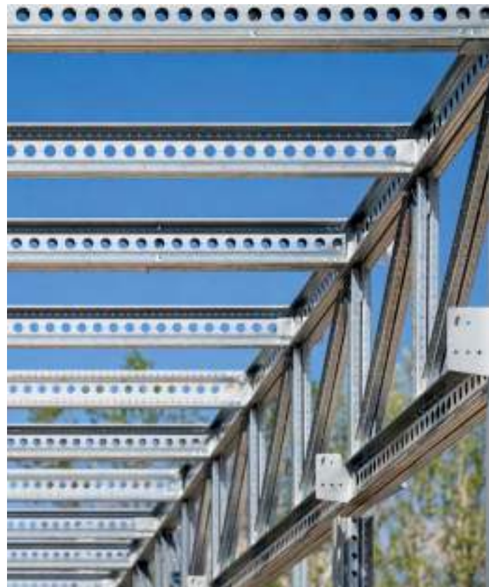
In alto fase di montaggio di una campata reticolare, a destra immagine di dettaglio dell'impianto
