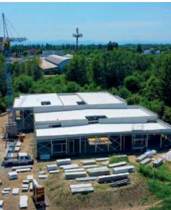
In alto foto panoramica di cantiere, a sinistra montaggio copertura
